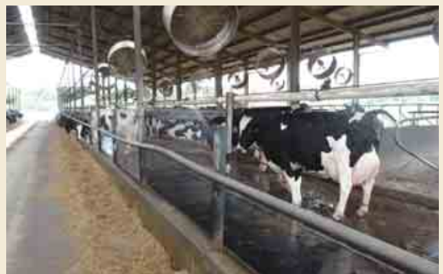
オープンリッジ牛舎の内部
