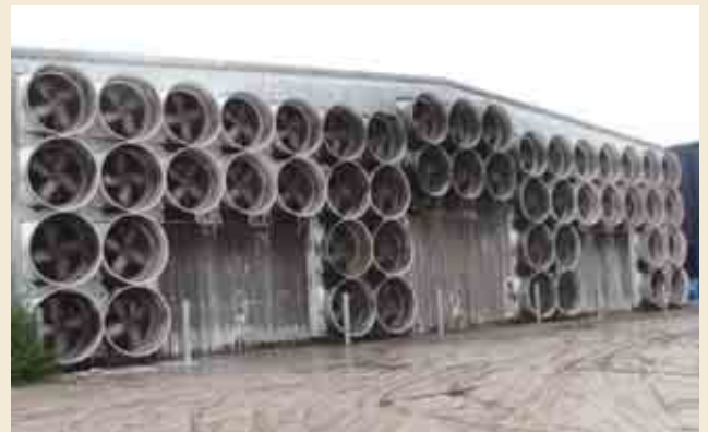
トンネル換気式牛舎の外観。52インチのファンが並ぶ
