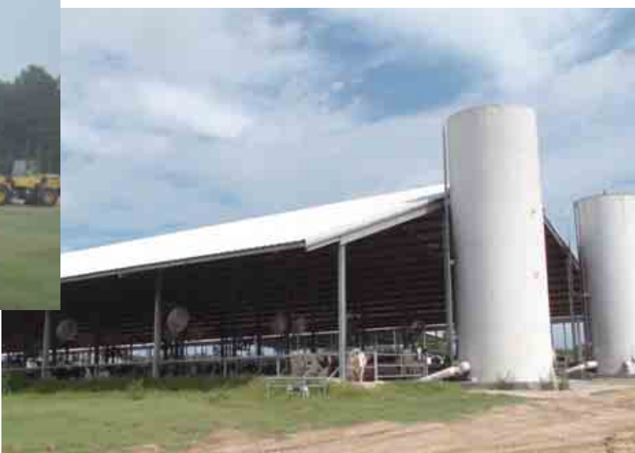
牛舎そばに設置されたスラリーの貯留タンク
