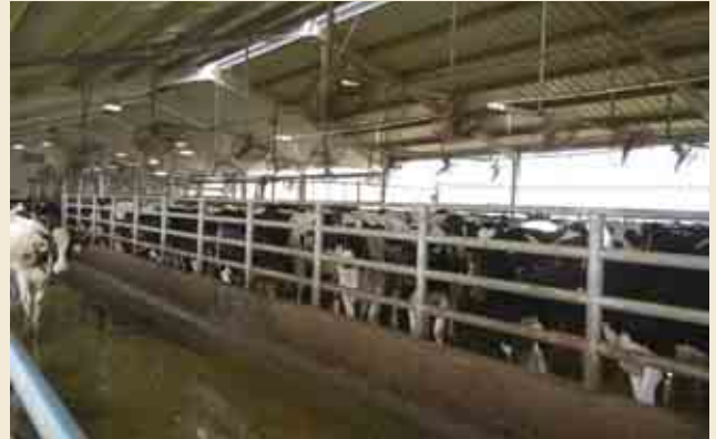
オープンリッジ牛舎の内部
