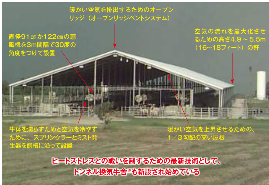
図3 オープンリッジ牛舎の構造
