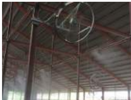
図5 | 自然の風の流に沿ってファンを設置
