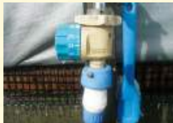
図2 | 定量止水栓。10~450リットルの範囲内で流量を決められ、蛇口に付けられる。
