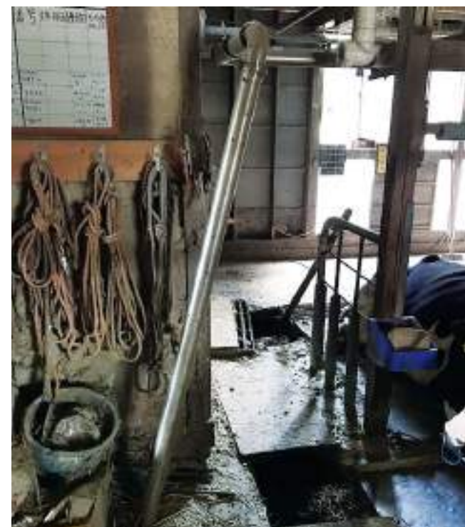
写真2: U字溝につながるミルクライン。地下へ埋設する事により作業動線の邪魔をしない構造となっている。
