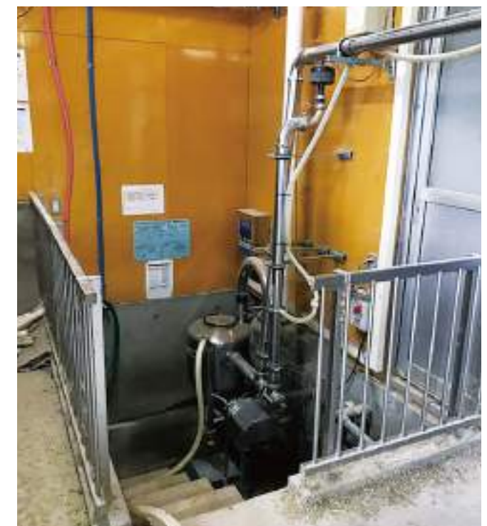
写真4: この構造により、ミルクライン内に残留する生乳量を最小限に抑える事ができる。
