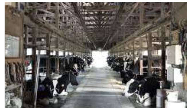
写真1: 牛舎内部。写真右側に処理室があり、左側のミルクラインが地下へ埋設されている。エアラインは自動給餌機の動線を妨げないように、レールの上部に設置。また奥から手前にかけて緩く傾斜がついている。
