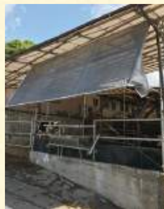
西日避けに 寒冷紗を設置
